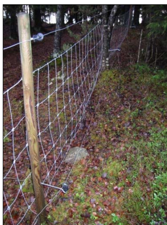
Figur 4. Utbedret nettinggjerde med strømtråd oppe og nede (Foto: Norsk viltskadesenter, Bioforsk Nord Tjøtta/ Inger Hansen).
