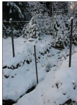
Figur 6. Eksempel på sikring av grøft ved hjelp av supplerende tråder (Foto: Norsk viltskadesenter, Bioforsk Nord Tjøtta /Inger Hansen).
